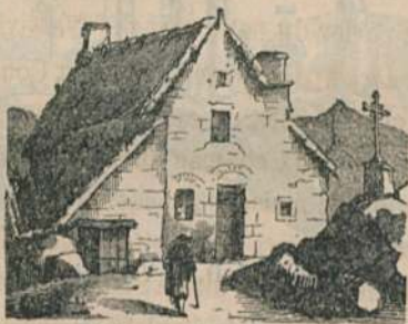
Maison à Vassivière.
