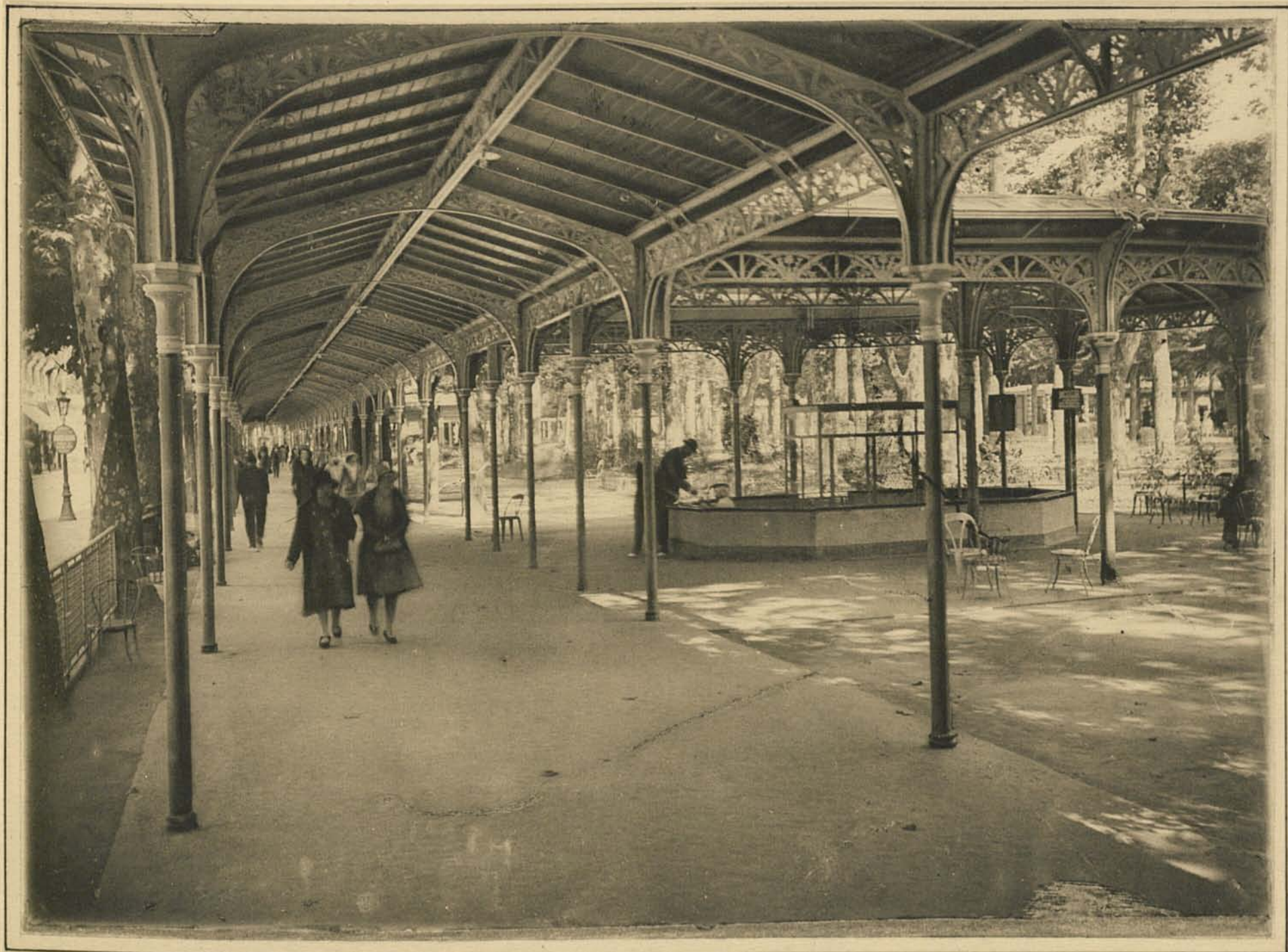
Galleries couvertes et Source du Parc
