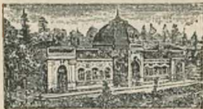
Vue de l'Etablissement Thermal de Saint-Yorre
