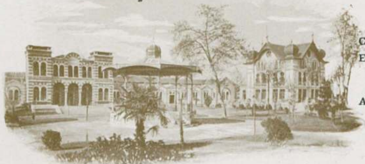
ENSEMBLE DE L'ÉTABLISSEMENT, DU PARC ET DU CASINO
