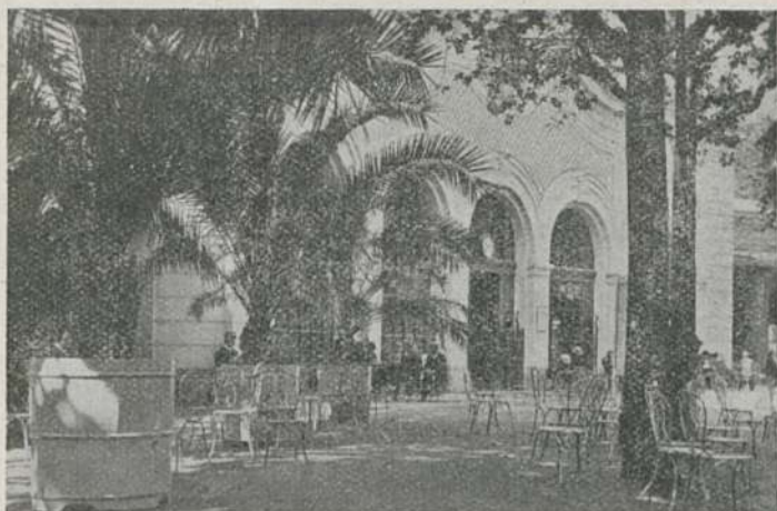
SALLE DE REPOS DE LA SOURCE DE L'HOPITAL
