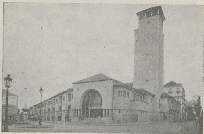
LE NOUVEL ÉTABLISSEMENT THERMAL
